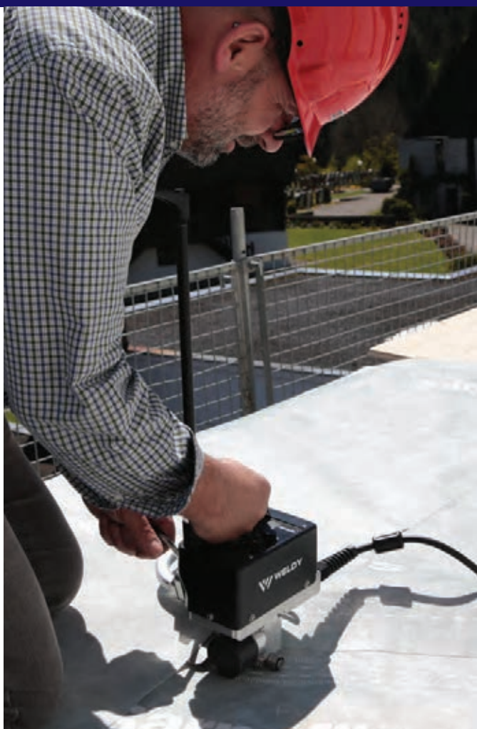
158.977 Нагревательный клин 40 мм, нержавеющая сталь (для ПВХ)
